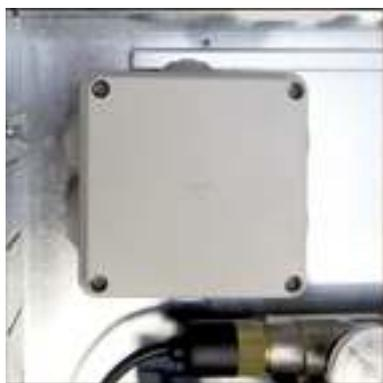
Поставляемая логическая схема насоса включает в себя все соединения, необходимые для правильной работы регулировочного блока: разрешение котла (НО), термостат помещения (ТП), предохранительный термостат (ПТ) и питание циркуляционного насоса (НАСОС). На электропитание должно подаваться напряжение 230 В.
